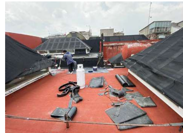
Trabajos de impermeabilización, mayo 2023.
